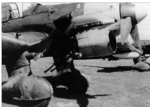
Sirenas de picado. Se aprecian perfectamente en esta imagen los mecanismos denominados "Sirenas de picado" (hubo otros modelos mejorados posteriores). Su ubicación en las carenas de las ruedas y la pequeña hélice en la que terminaba este primer modelo, eran características que, a simple vista, determinaban la presencia o no del mecanismo en el avión correspondiente. Foto: "Luftmacht Deutschland" Essener Verlagsanstalt. Essen, 1941.
