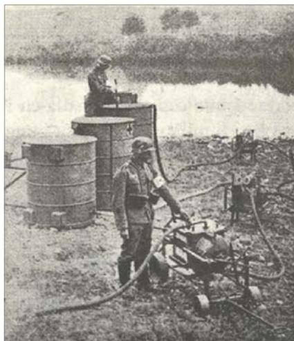
*Foto 0. Equipo de potabilización y camión de farmacia con bidones de agua. Grandes contenedores cilíndricos de 500 litros fueron empleados en maniobras de descontaminación. En este caso la fotografía ilustra las labores de depuración de aguas contaminadas por parte de una unidad farmacéutica de la Wehrmacht. También podían emplearse cuatro bidones más pequeños de 250 litros.*
