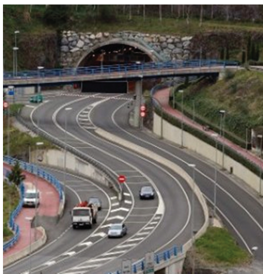
La alcaldesa de Bilbao impulsó el túnel de Artxanda, que conectaba Bilbao con el valle de Asua, dentro de su programa de impulso a las comunicaciones.
